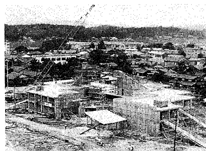
S 43.6 県立図書館建築工事の状況
