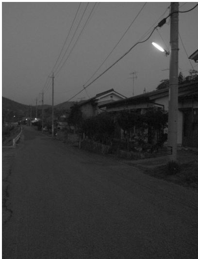
防犯灯の整備
