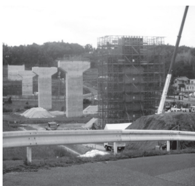
建設中の山陰自動車道
