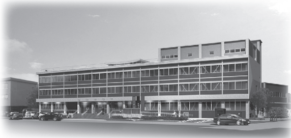
市役所本庁舎耐震化事業
