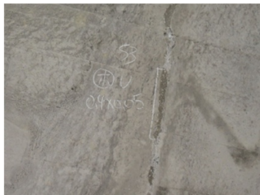
写真 2-2 トンネル変状事例
