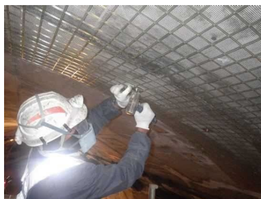
写真 3-1 FRP ネット設置状況
