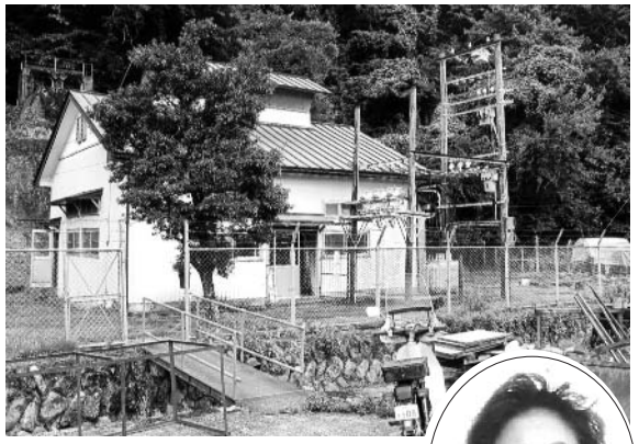
柿木小水力発電所
