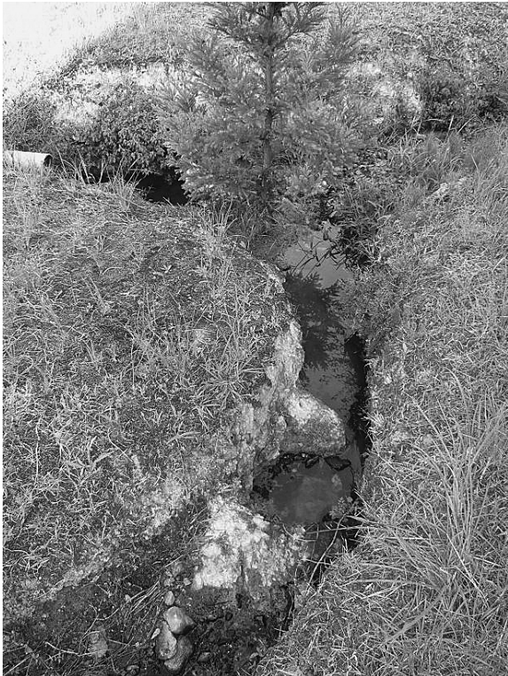
整備が求められる排水路
