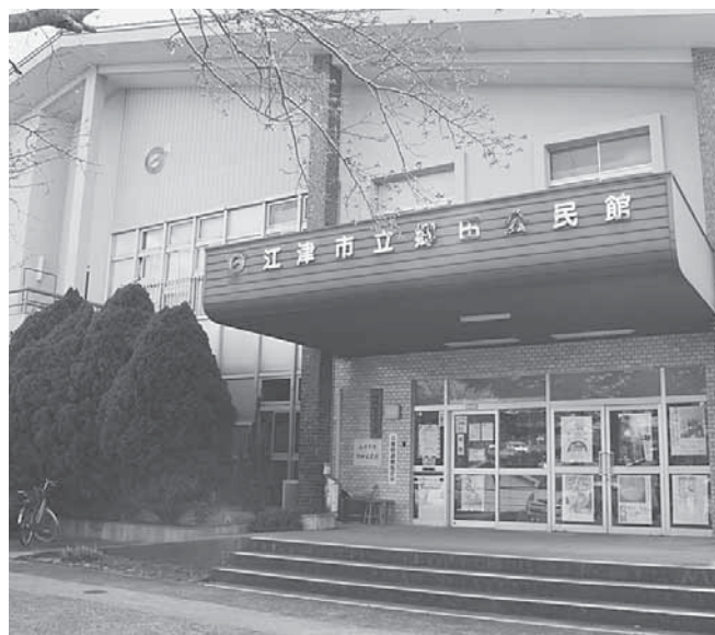
建物の1階を図書館として利用
