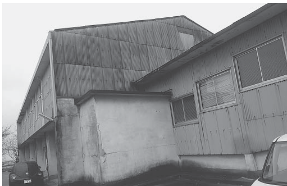
老朽化が進む津宮小体育館
