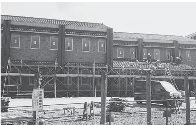
建設中のひと・まちプラザ
