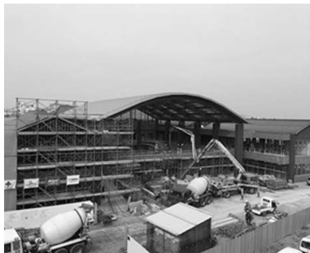
(建設中の江津ひとまちプラザ)
