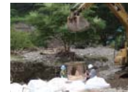
今年から本格的な復旧作業が行われていく予定となっております。
