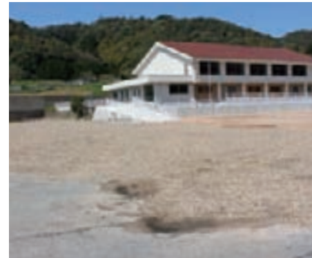
解体工事が終わった建設予定地
