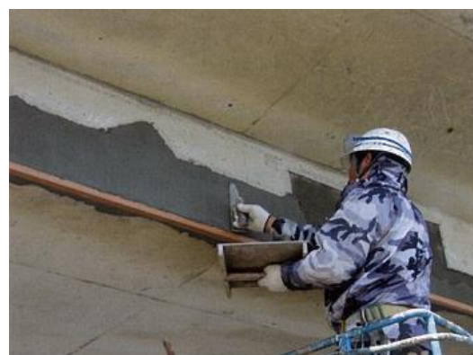
写真4-3 断面修復状況
