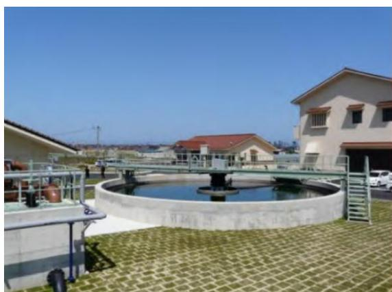
手前が紫外線最終沈殿池、奥左が管理棟、右が機械棟
