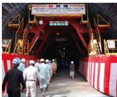
▲湯抱トンネル
