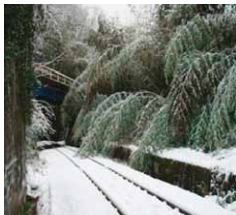
▲雪の重みで竹が倒れ線路を塞いだ状態
