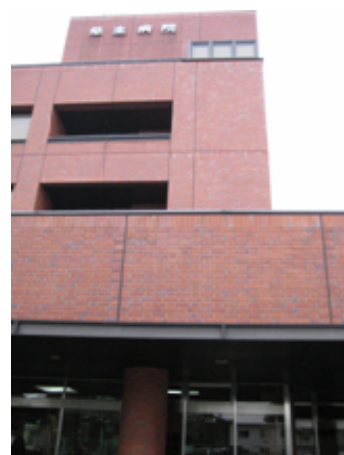
慈圭病院エントランス
