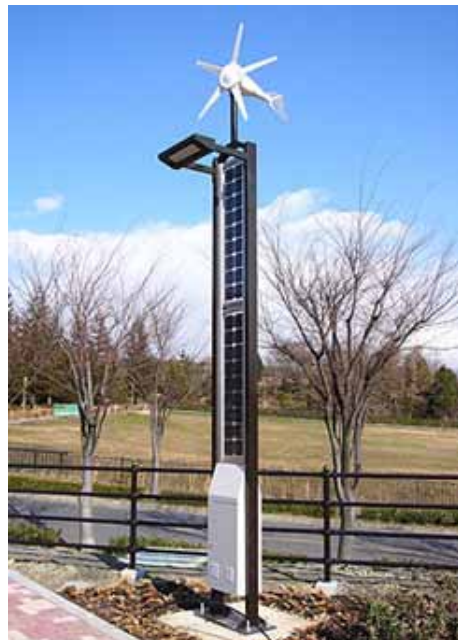
図表 4-3 ハイブリッド灯の設置事例
