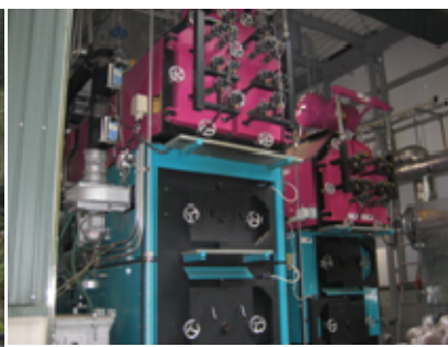
木質チップボイラ・2 基
