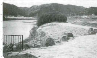
木路原堤防で整備が進められている親水公園（左側が江の川）
