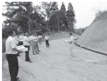
町道中倉日向線改良工事
