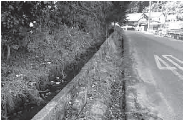
因原地区 水路写真
