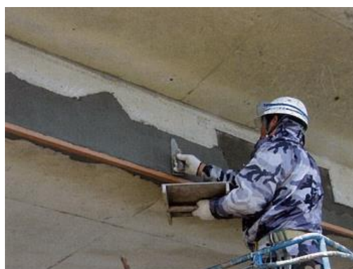
写真4-3 断面修復状況
