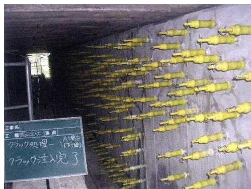
写真4-2 ひび割れ注入状況
