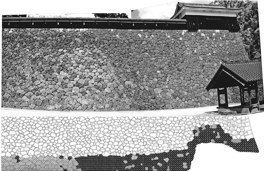
図28 石垣E38では右側（北側）に忌部安山岩（暗灰色の石）が多く見られ、左側（南側）は森山石（明灰色の石）が多く使われている。忌部安山岩は近代の補修によるものである。
