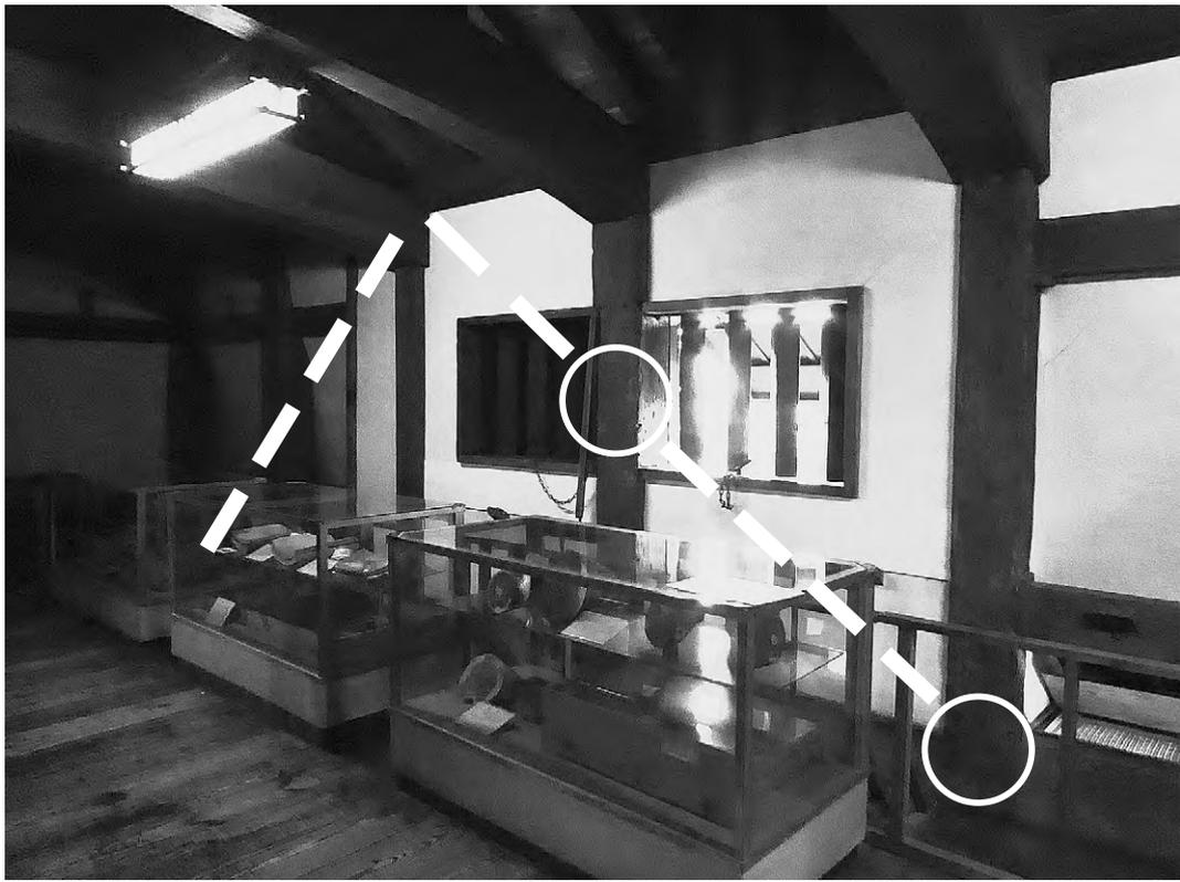
図13 天守内部2階 東側北「貫跡」(白丸) 千鳥破風(点線)
