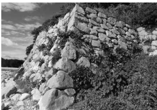
6. 萩城 荒川櫓北東隅
