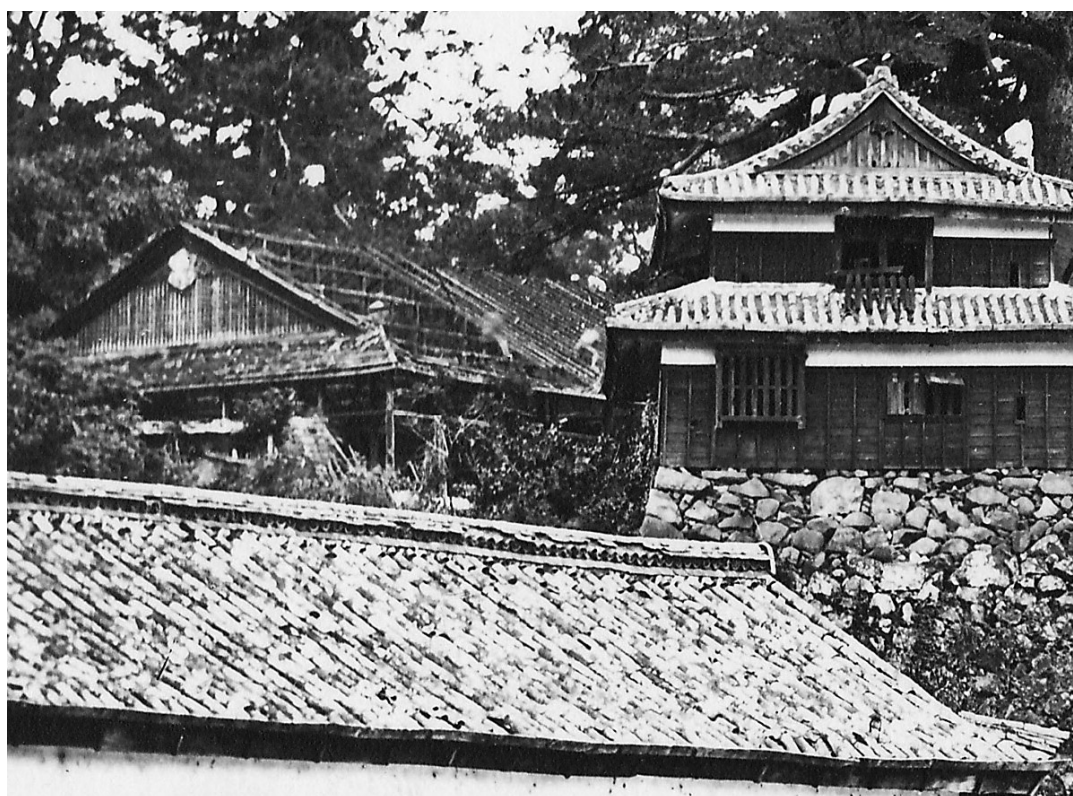
【写真Dの部分拡大】二之丸内の御書院、南櫓（御書院屋根の解体作業、南櫓二階窓格子の取り外し途中の様子が確認出来る。御書院屋根には作業中であろう人物が複数写る。）
