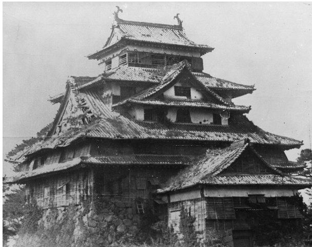
【写真A】の天守(推定:明治25年8月頃～明治27年6月頃)
