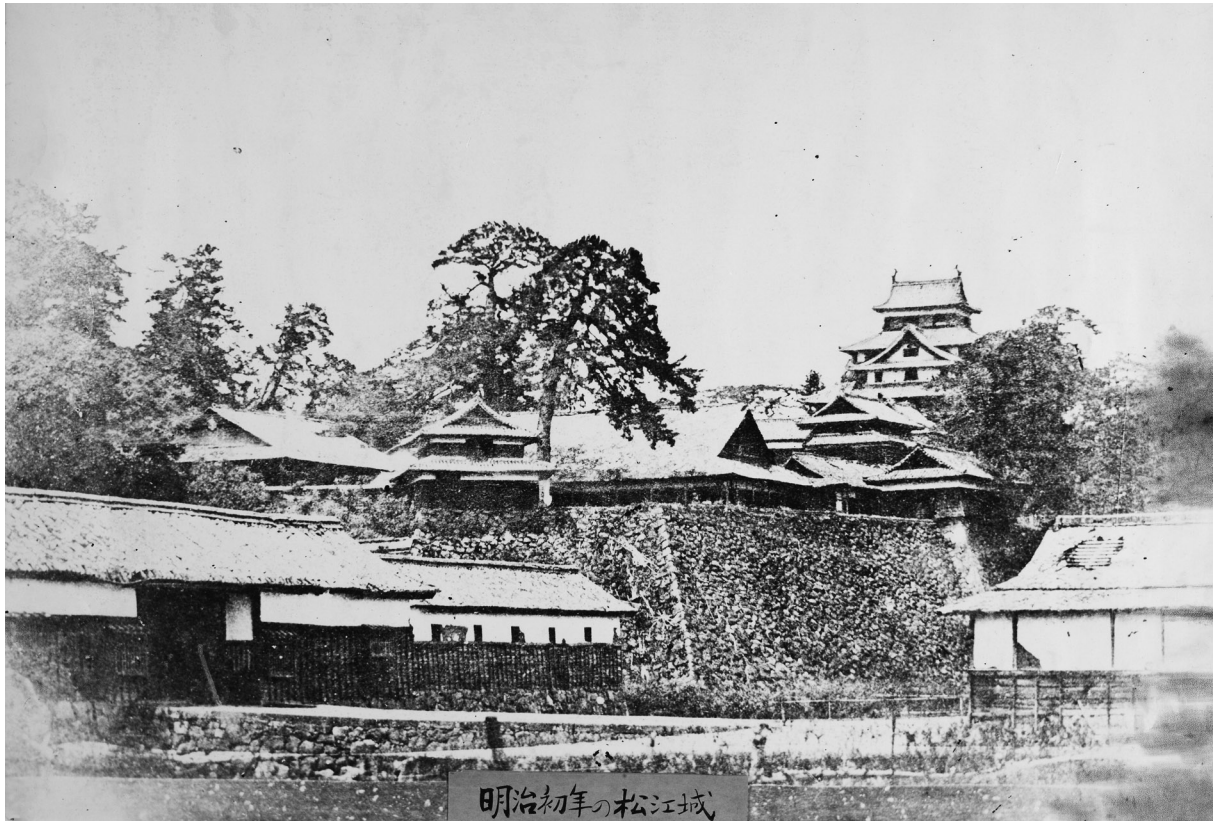
【写真C】松江城古写真(明治8年以前:現存する二番目に古い松江城天守の写真)(天守5階で掲額写真)
