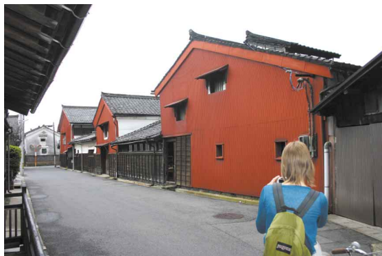
松江市石橋町の醤油屋界隈
