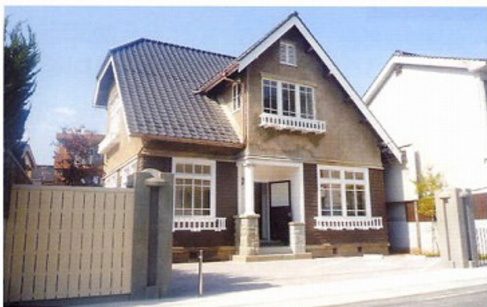
戦前の状況に修復復元された島根大学旧奥谷宿舎外観
