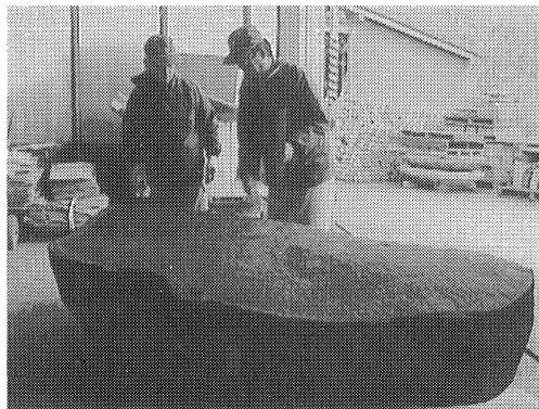
写真24 天井石の加工(余分な部分を落とす)
