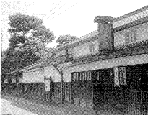
写真34 現在の木幡邸 宍道本通りから。塀の上に高く枝を伸ばしているのは、東郷大將が植えた松。
