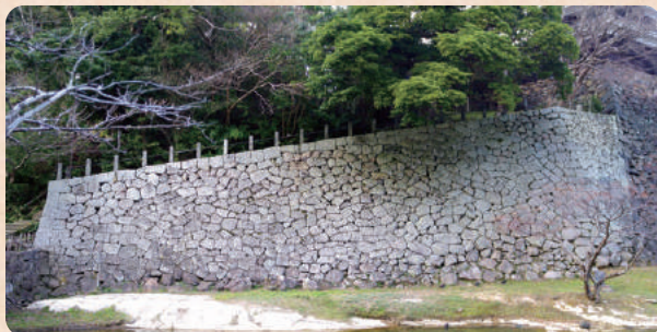
▲切込接 御廊下橋(千鳥橋)北詰石垣
