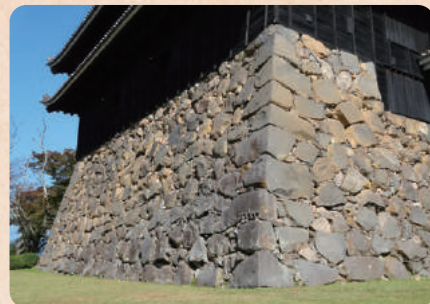
▲打込接 天守台石垣(南西から) 写真：『松江市史 別編1 松江城』より転載
