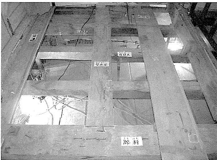
▲写真1 解体状況（解体箇所①）階段側から解体部分を見る。
