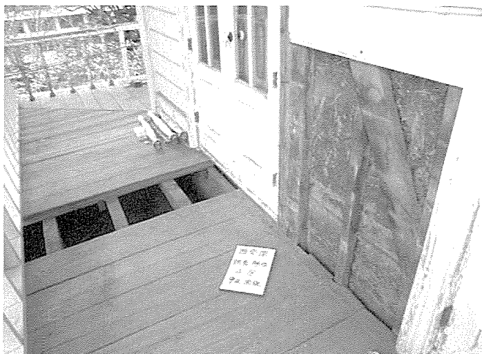
▲写真7 解体状況（解体箇所③）南東端部の床及び壁面.
