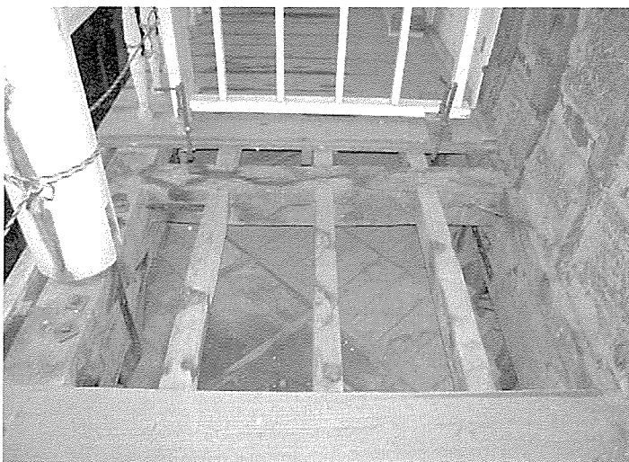
▲写真9 解体状況（解体箇所④）南側ベランダ中央部.
