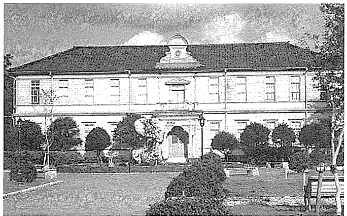
写真5. 旧富山県立農学校本館（明治36年）
