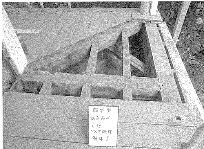
▲写真11 解体状況（解体箇所⑤）ベランダ南西隅部.
