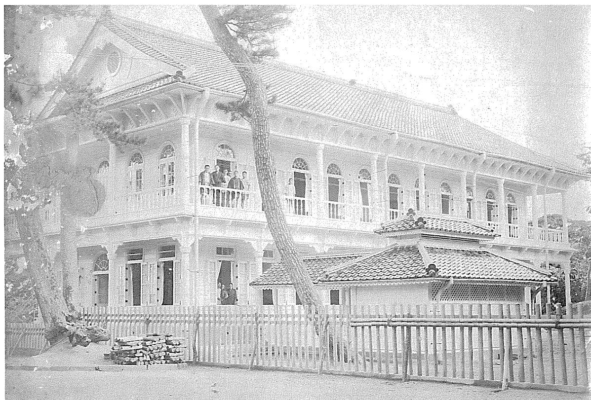
2 明治36年9月 松江市工芸品陳列所 竣工時裏面 (松江市蔵)
