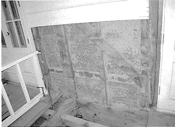
▲写真10 解体状況（解体箇所④）南側中央部壁面.
