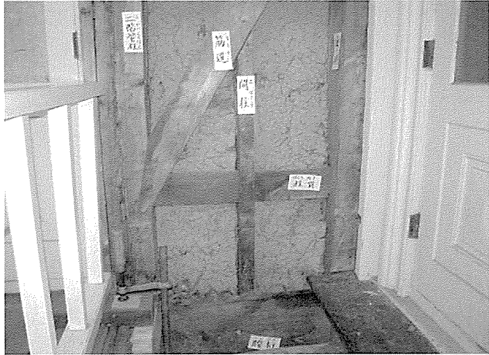
▲写真4 解体状況（解体箇所①）階段室北側の壁面をみる。
