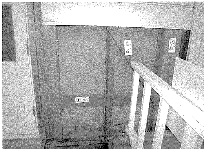
▲写真5 解体状況（解体箇所②）北側中央部床面をみる。
