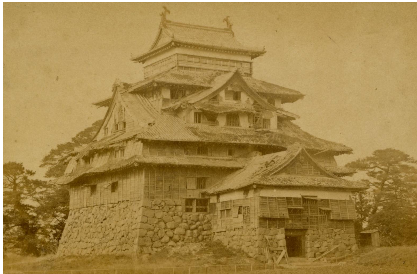
平成31年3月に新たに確認した松江城天守古写真〔推定：明治27年6月1日から同年9月30日の間の撮影〕
