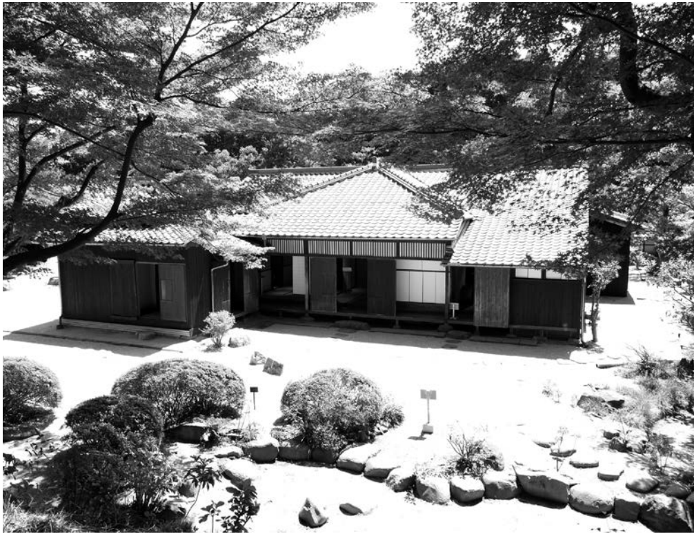
写真12 裏山から見た全景（修繕後）
