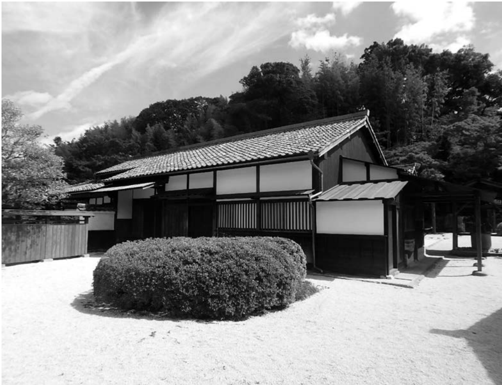
写真6 主屋正面（南面）門からのアプローチ 東側出っ張りは板屋根に変更
