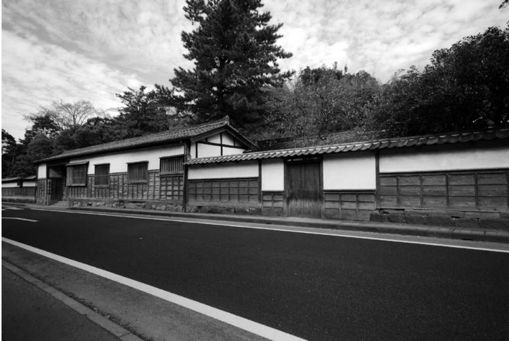
写真10 道路側から（南面）の長屋門
