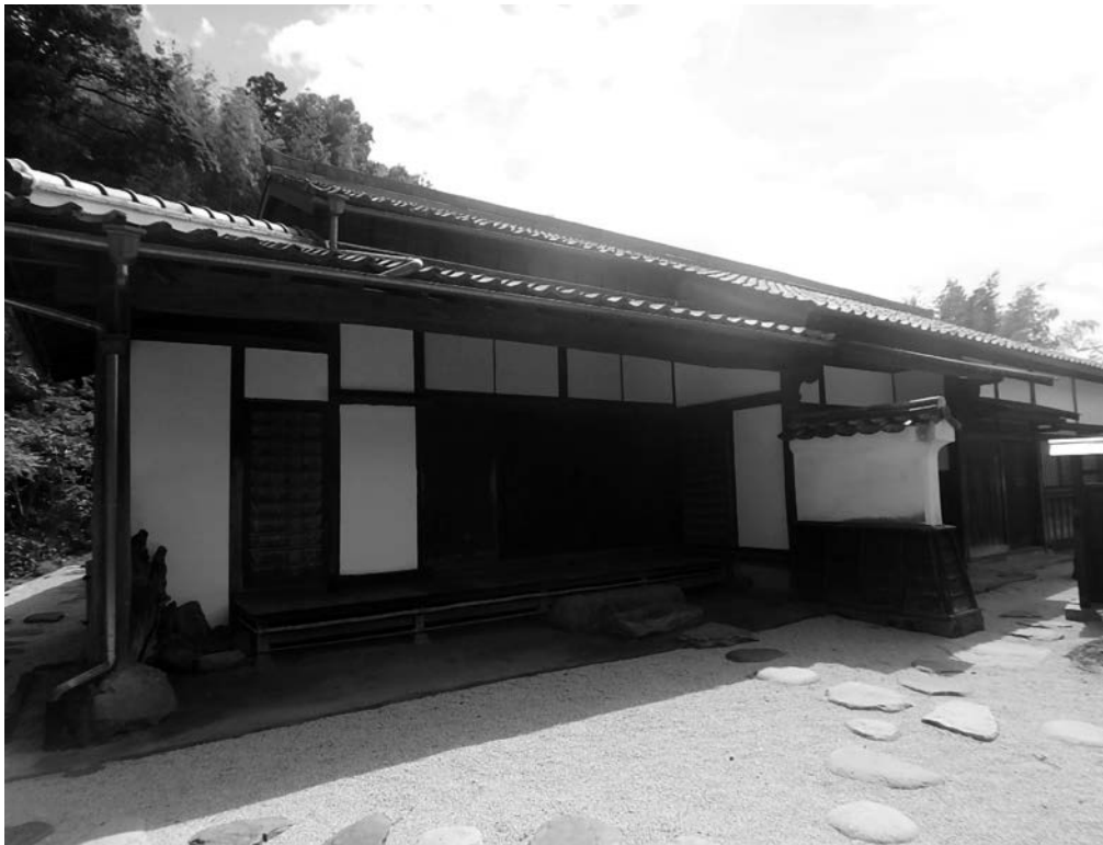
写真9 主屋の南面 座敷10畳前の土庇
