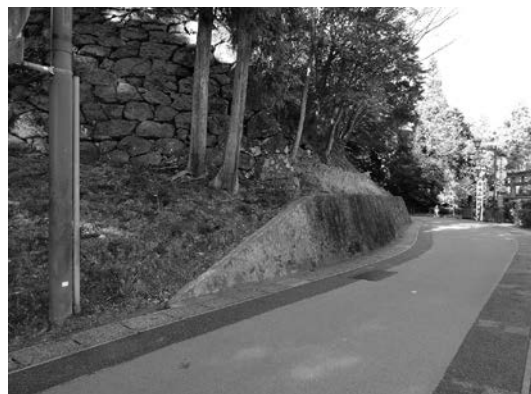
写真5 図4のC 松江護国神社北側市道沿いの コンクリート擁壁
