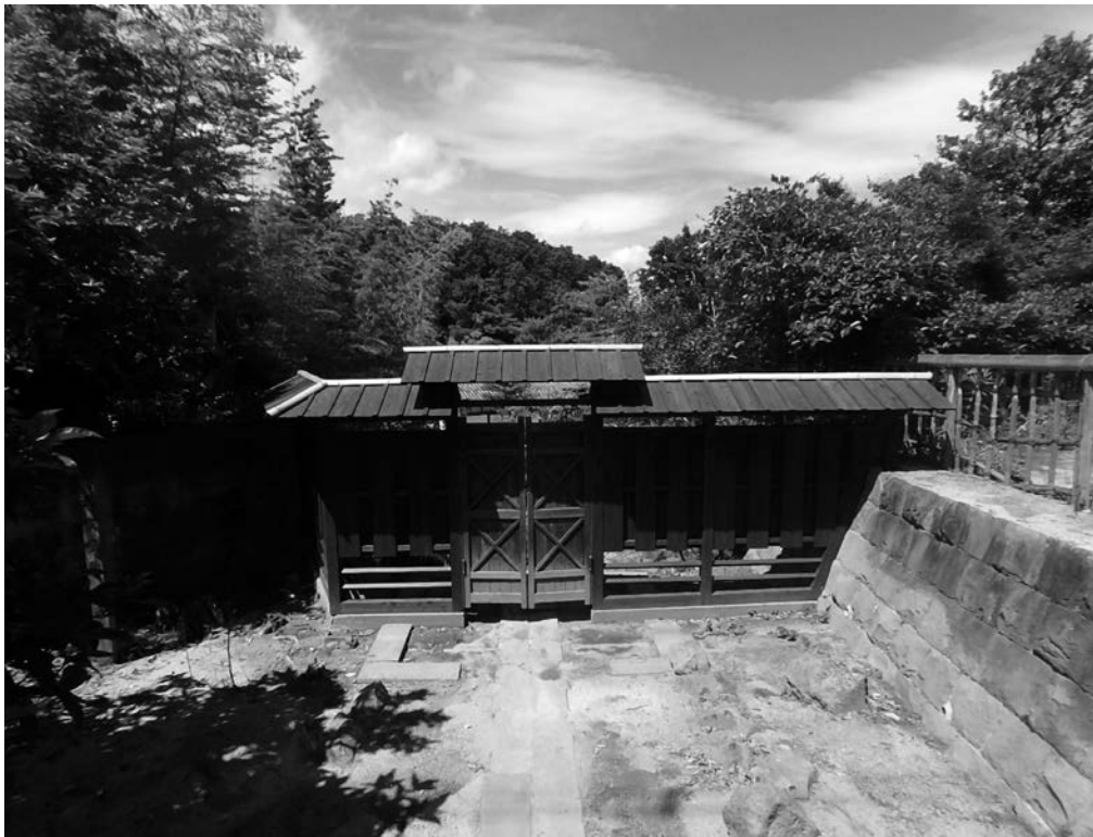
写真13 北側の裏門（修繕後）
