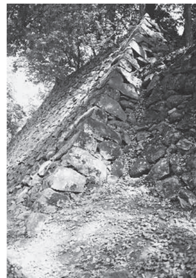
写真4 C18面(石垣修理前)
