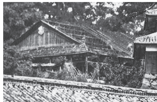
写真4 松江城古写真（明治8年） 取壊し中の御書院の屋根 屋根に反りはなく直線的である
