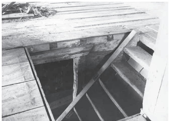
資料7 階段西側床梁にある小根太の小口彫 (松江城天守修理工事記録写真の一)
