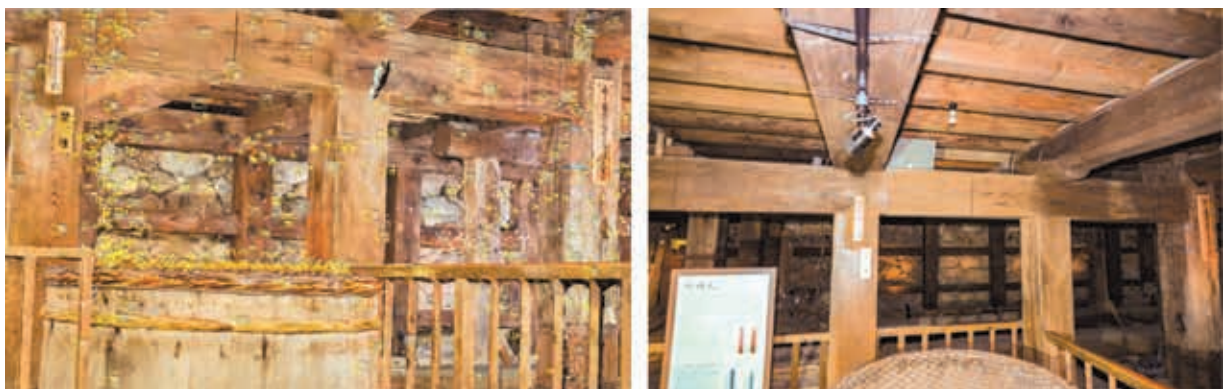
図4 同じ個所の3Dモデルとの比較 左写真測量による3Dモデル 右写真
