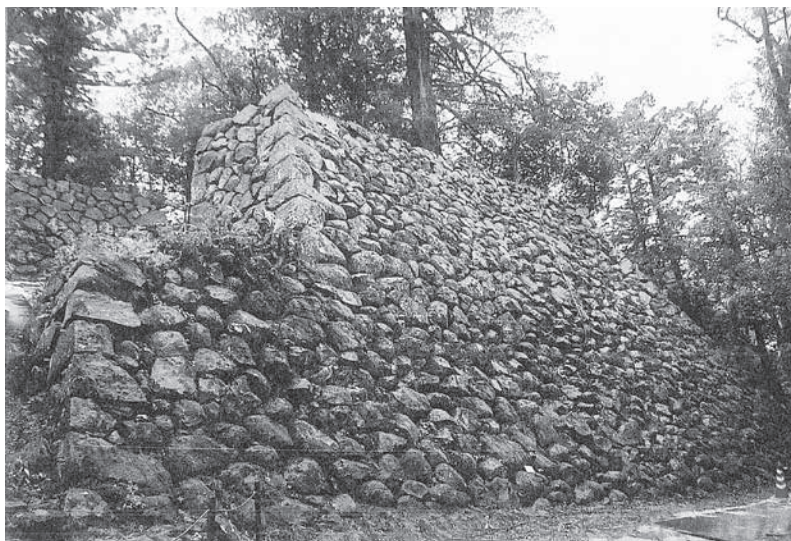
写真3 C17面(石垣修理前)
