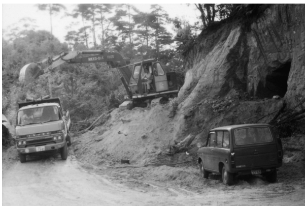
2号穴 採土工事で発見される
